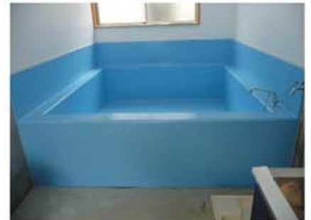
最後在伊凡特COAT PC200上施作防水塗料 Apply waterproofing coating on surface
