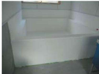
施作伊凡特COAT PC200完成之後 After application of COAT PC200
